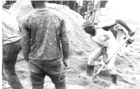
せっせとセメントと混ぜる砂をかき集める強靱な作業員。タフな彼らに誰も勝てない。
