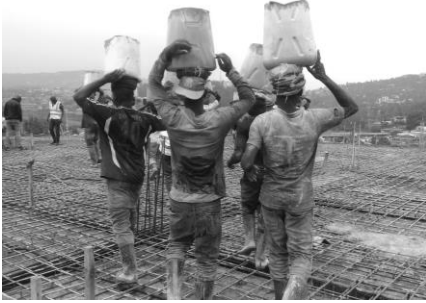
セメントを流し込む作業中。 頭の上に10キロ近いセメントを乗せ、何度も何度も運び込む。
