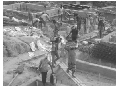
そしてまた始まった建設工事。 たくさんの人に手伝ってもらいながら、ジワジワ進めていきます。
